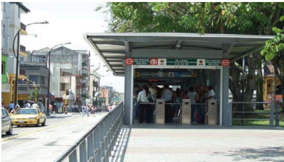
Figura 14. Un sistema completo de Bus Rápido, como el Megabus de Pereira (Colombia), tiene estaciones cuyas funciones son determinar el lugar específico donde los pasajeros pueden entrar y salir del sistema, además de proporcionar la facilidad de pago de pasaje antes de abordar.
